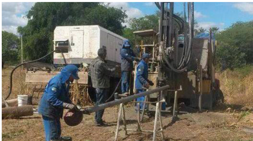
Perfuração de poço na comunidade Sítio Piranhas em Rafael Godeiro, um dos municípios beneficiados
